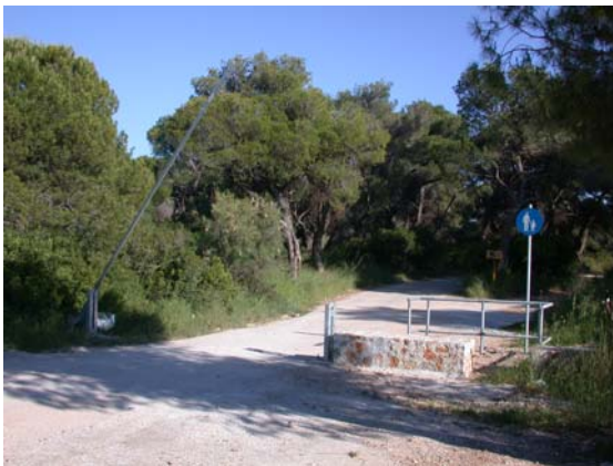
Εικόνα 7.1: Μπάρες και κατάλληλα τεχνικά έργα για τον περιορισμό της κυκλοφορίας (17.05.2006)
