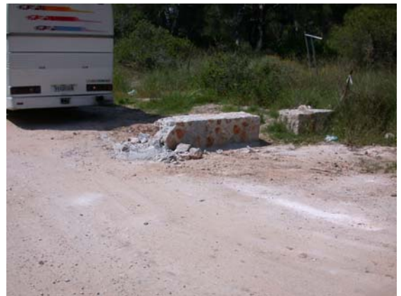
Εικόνα 7.2: Κατεστραμμένη μπάρα και βανδαλισμένο τεχνικό έργο για τον περιορισμό της κυκλοφορίας (20.05.2006)
